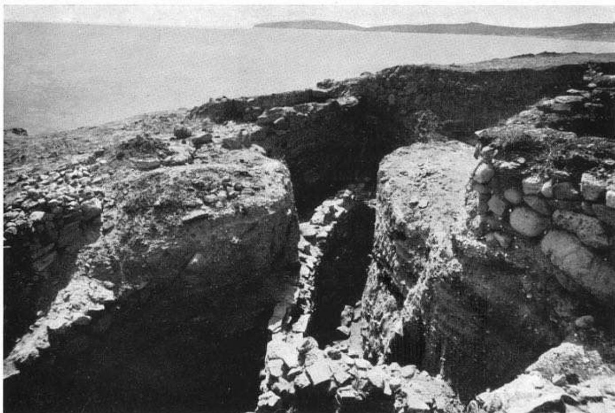
FIG. 140 - DISCARICA SETTENTRIONALE. L'EDIFICIO 206, VISTO DA NO.
