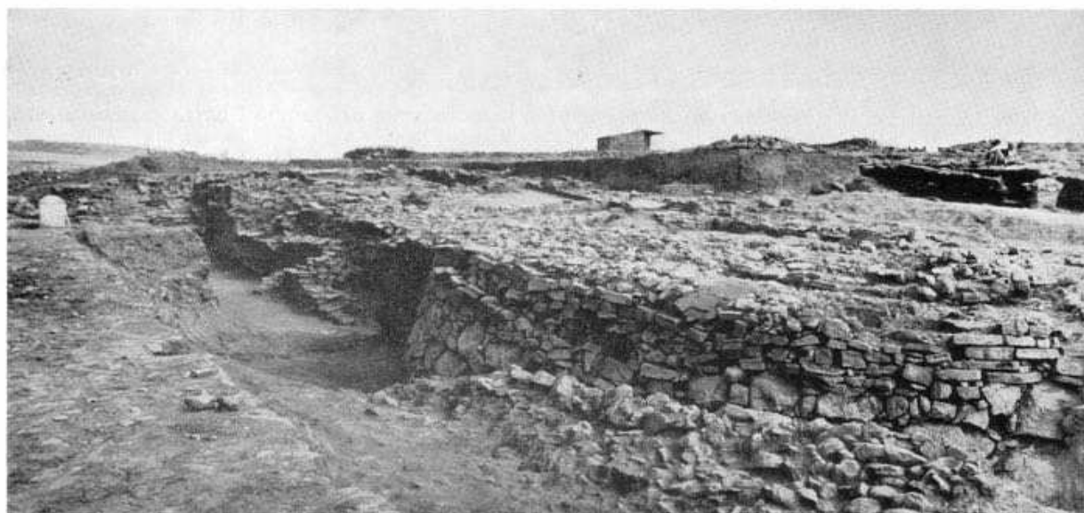
FIG. 150 - IL BASTIONE 34 E LA CORTINA 35, 36, 37, VISTI DA SO AL TERMINE DELLO SCAVO 1934.
