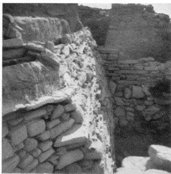
FIG. 75 - LO SPIGOLO FORMATO FRA I TRATTI 5a e 5b DELLA CORTINA MURARIA PIÙ ANTICA. NELLO SFONDO IL TRATTO TRASVERSALE 4 (foto S. Puglisi 1935).
