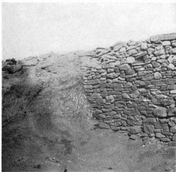
FIG. 125 - LA CORTINA MURARIA DELLA PRIMA CINTA, IL CUI PROSPETTO È STATO MESSO IN LUCE DAGLI SCAVI 1934-1936, NEL PUNTO IN CUI SCOMPARE ENTRO LA GRANDE DISCARICA DEL PERIODO AZZURRO FORMATOSI ALL'ESTERNO DI ESSA. IN ALTO, SULLA DISCARICA L'INIZIO DELLA SECONDA CINTA MURARIA (CORTINA 15).
