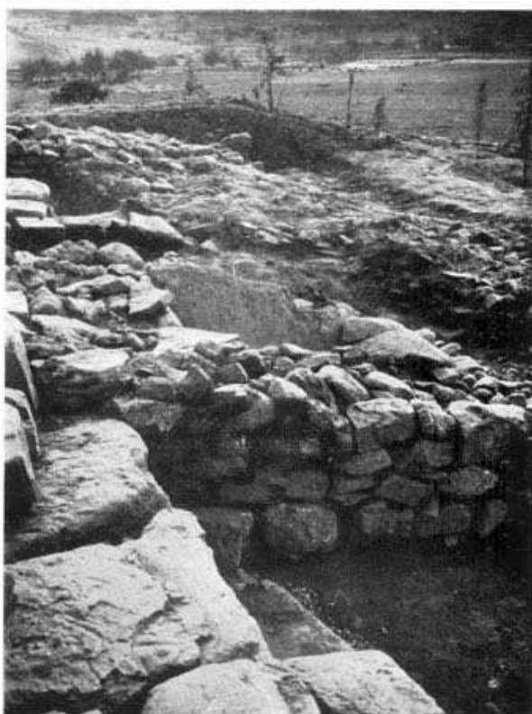
FIG. 126 - LA CORTINA 15 DELLA SECONDA CINTA (A SIN.) E LA VASCA 17 AD ESSA ADDOSSATA, VISTE DA NORD.
