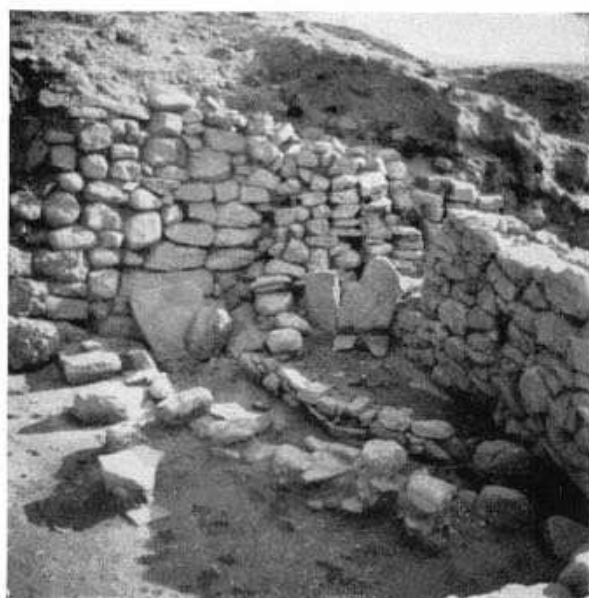
FIG. 81 - CANALE DI DRENAGGIO SOTTO IL SUOLO DELL'EDIFICIO 1150 ALL'ESTREMO SÈ DELLE MURA URBICHE. (foto Pugliesi, 1935).
