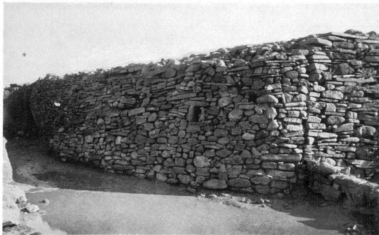
FIG. 64 - LE MURA AL TERMINE DELLA CAMPAGNA 1936. IL TRATTO 12.
