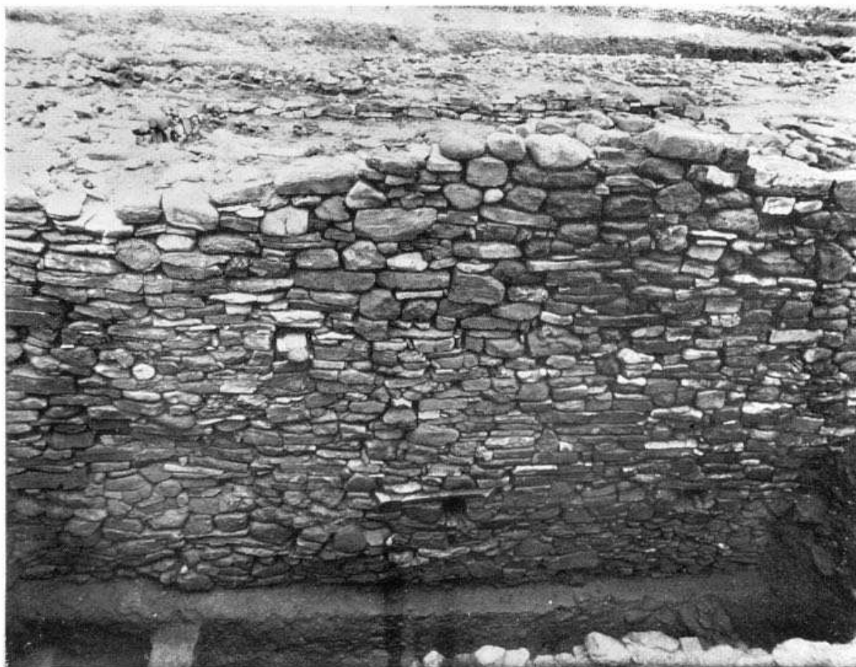
FIG. 119 - LA PARETE OCCIDENTALE DEL VANO 28, METÀ SUD, VISTA DA EST.
