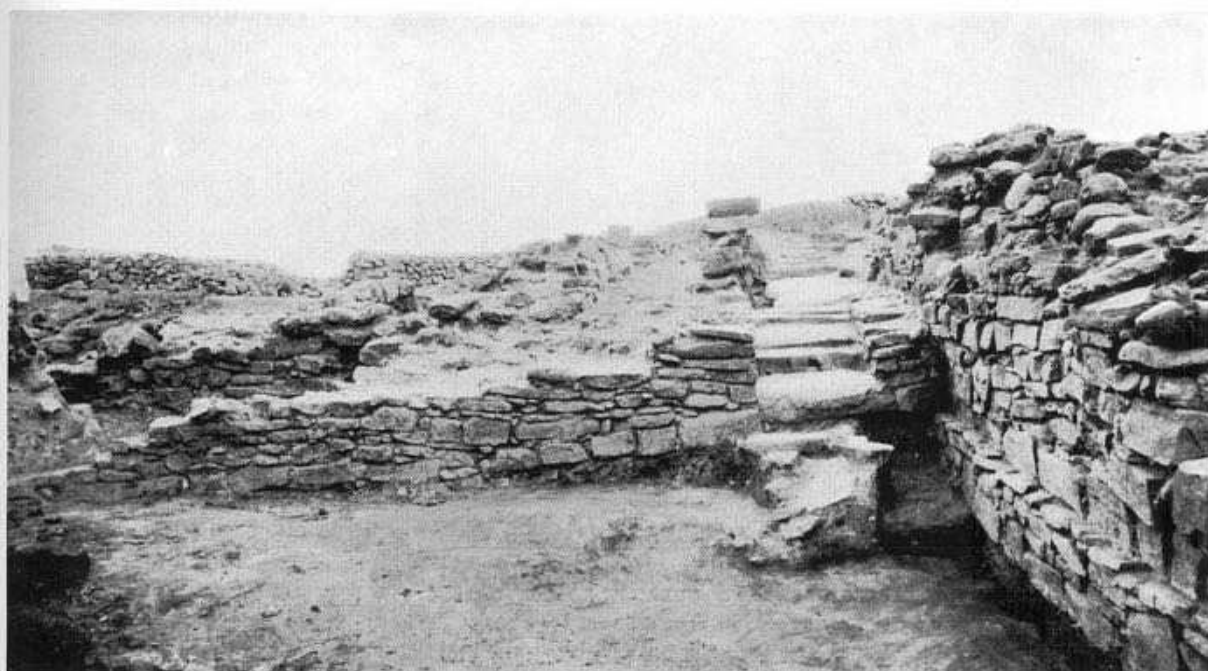
FIG. 163 - IL BASTIONE TRAPEZOIDALE XIX AL TERMINE DEGLI SCAVI 1934.
