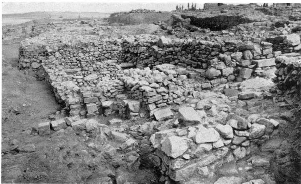
FIG. 169 - LE FORTIFICAZIONI DELLA PORTA 101, LA TORRE 23, L'EDIFICIO X E IL BASTIONE CURVILINEO 34, VISTI DA SUD.
